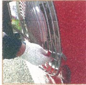
2. 下段部の磁石ブラケット付着)及び引張固定スプリング付着
